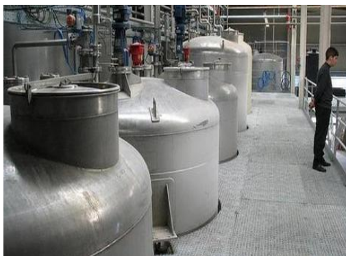
Figura 7.4 Tanques de biocombustible
